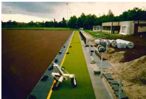
Foto's boven en rechts: In de maanden juni, juli en augustus is koortsachtig gewerkt aan het uitgraven van het grasveld, storten van de onderlaag en strak neerleggen van de nieuwe mat.
